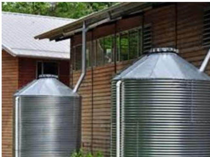
Gambar 5.22. Bak Air untuk Panen Air Hujan
